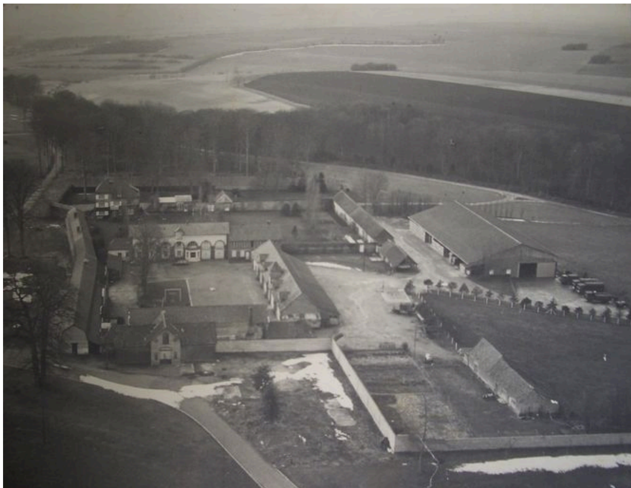
Vue aérienne de la ferme.
