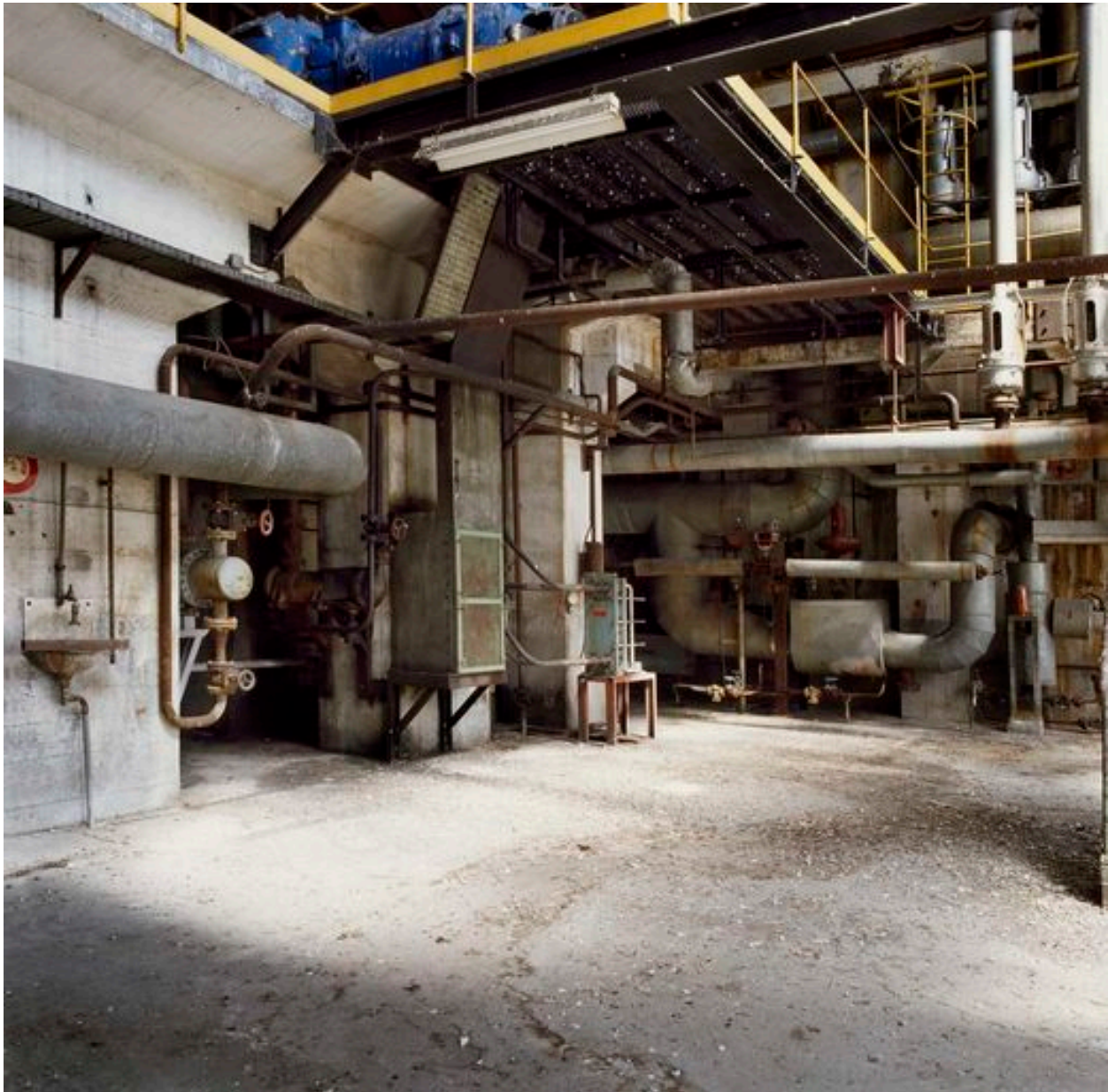
Rez-de-chaussée de la centrale vapeur.
