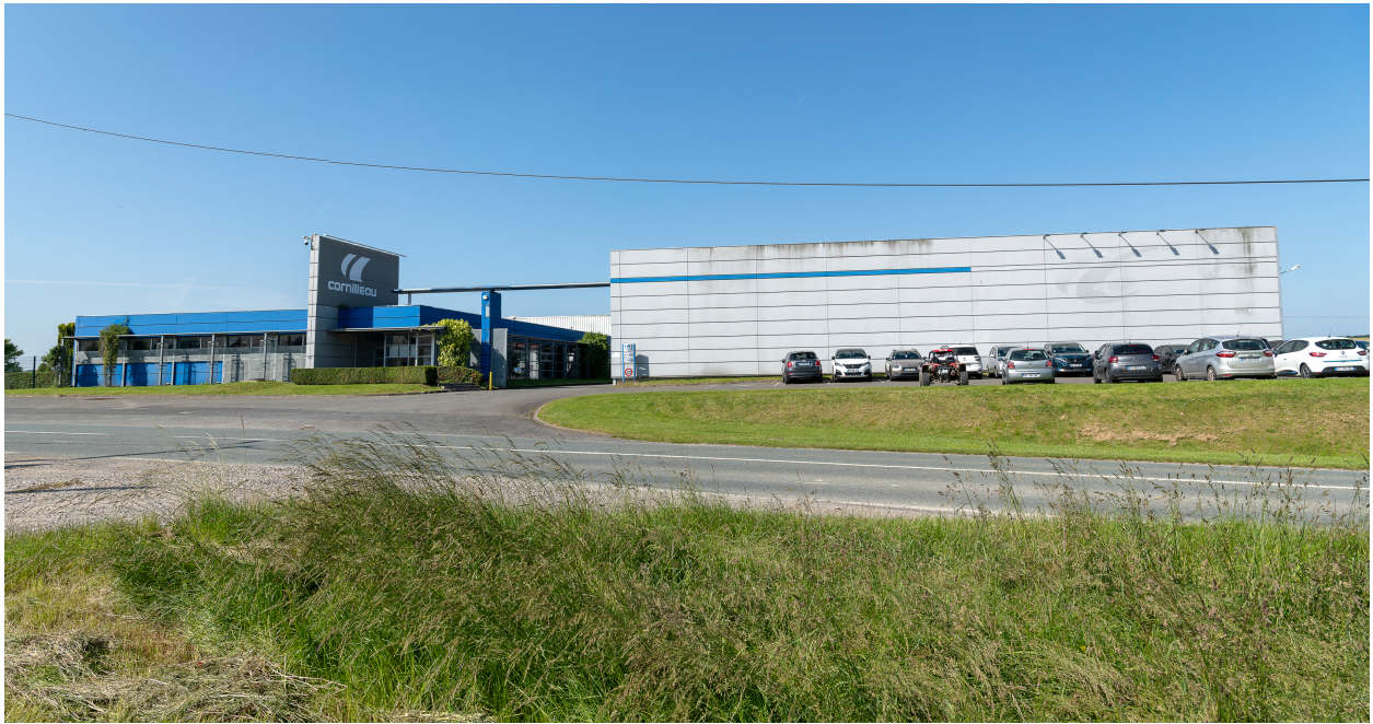
Vue générale de l'usine prise depuis la route D1001.
