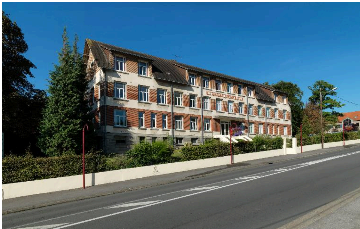
Vue d'ensemble sur rue.
