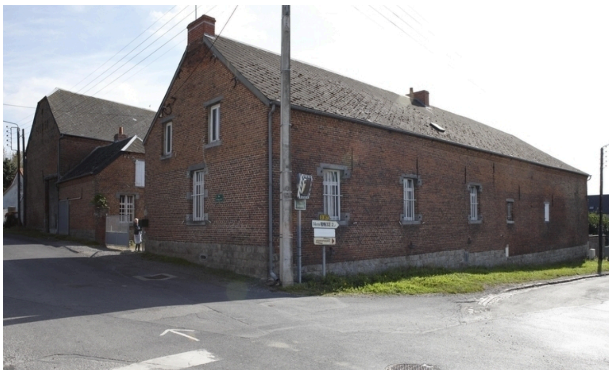
Vue de la ferme, depuis l'angle entre la D87 et la rue Albert-Fenez.
