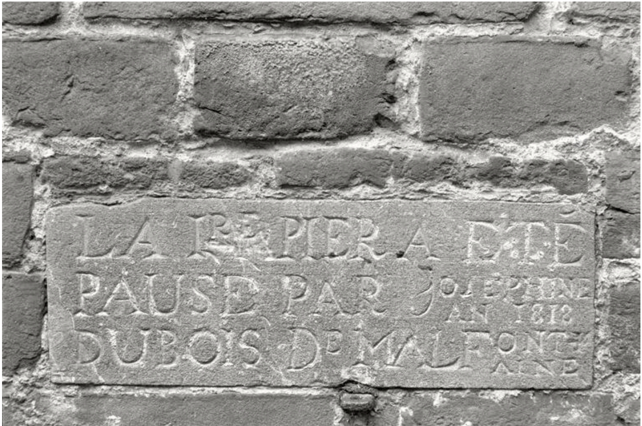
Vue de la pierre de fondation du corps de bâtiment.
