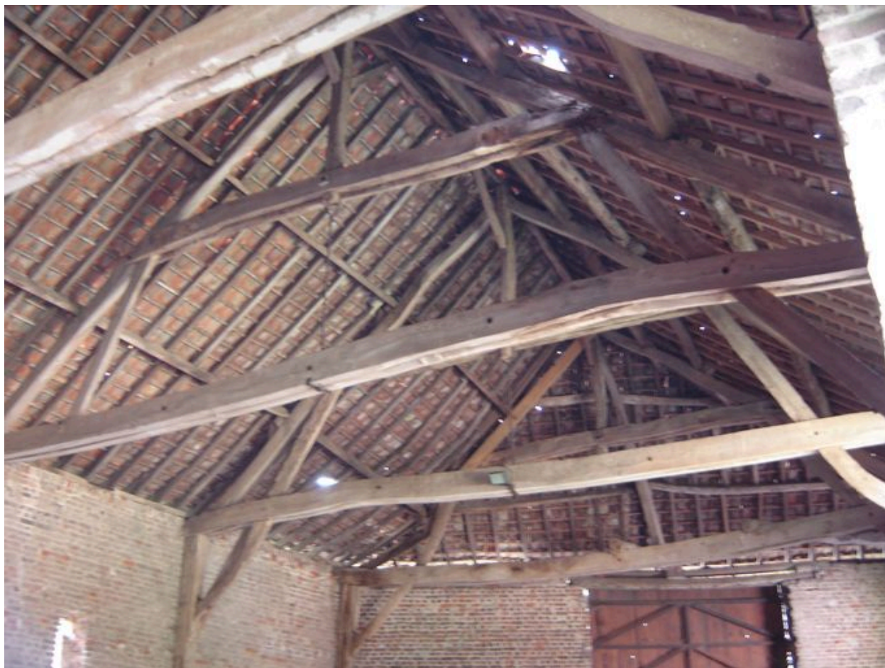
Vue de la charpente.
