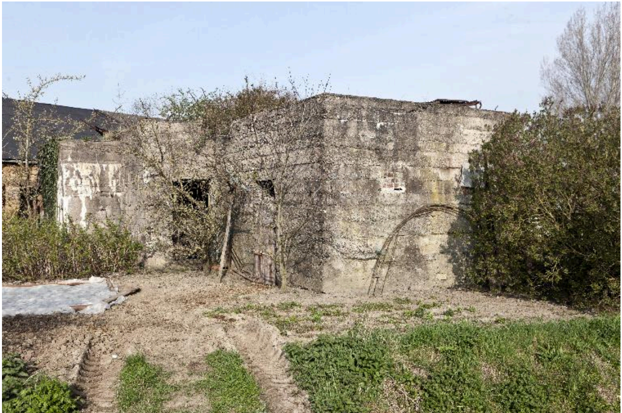
Vue de trois-quarts vers le nord-ouest
