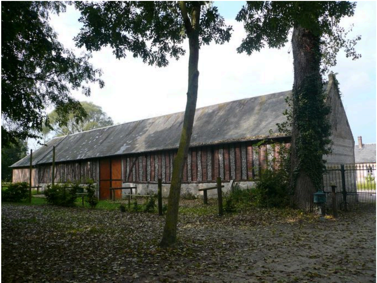
Vue de la grange au sud-ouest de la cour.
