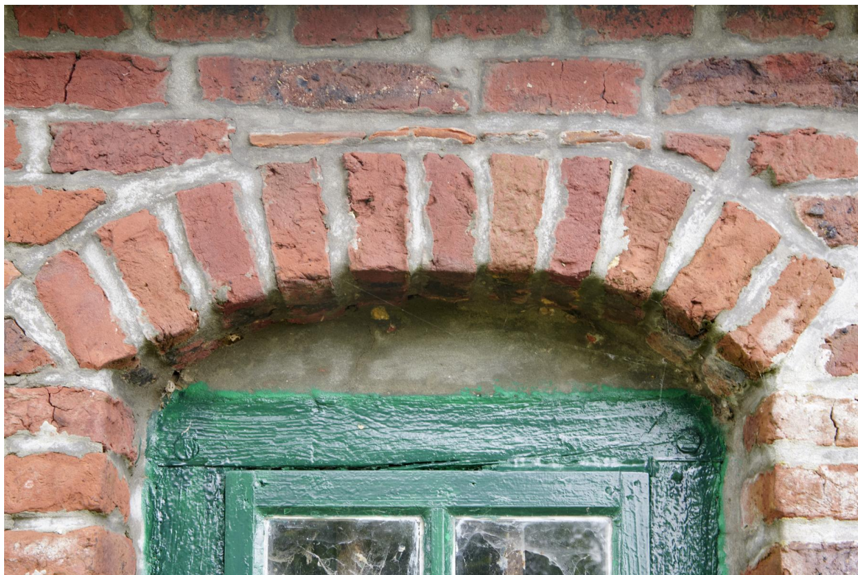
Baie sud, détail de l'arc surbaissé.
