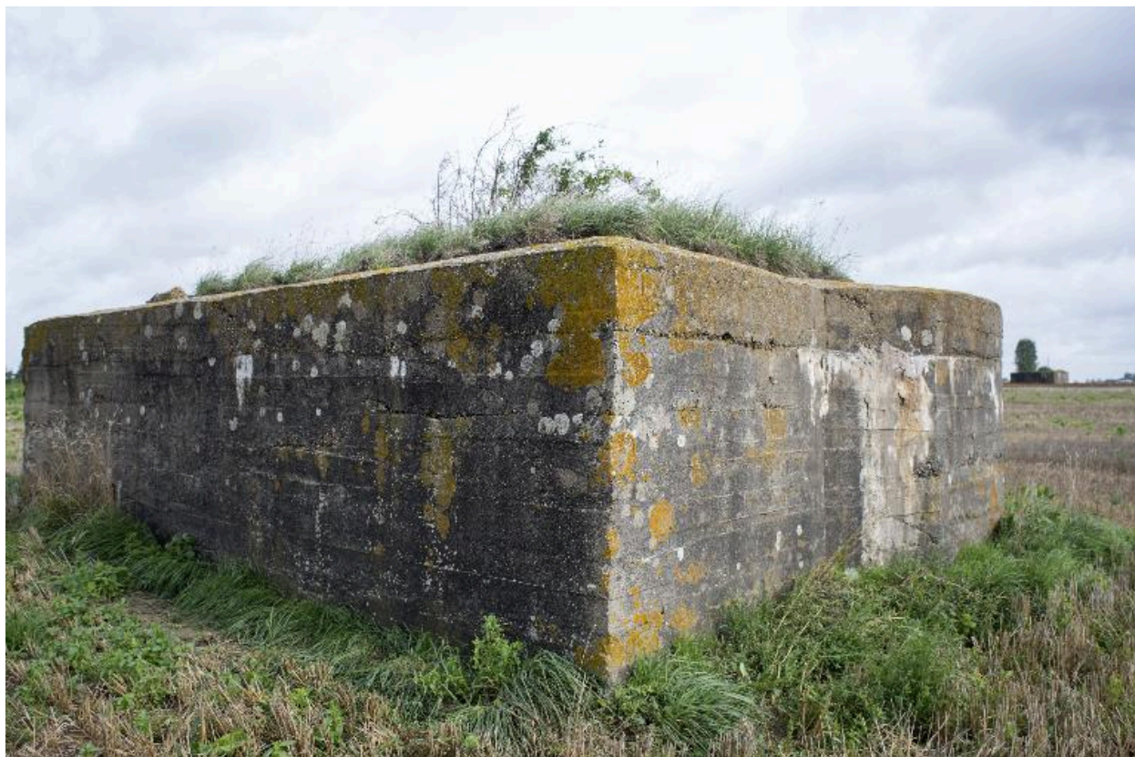
Vue de trois-quarts arrière, vers le nord
