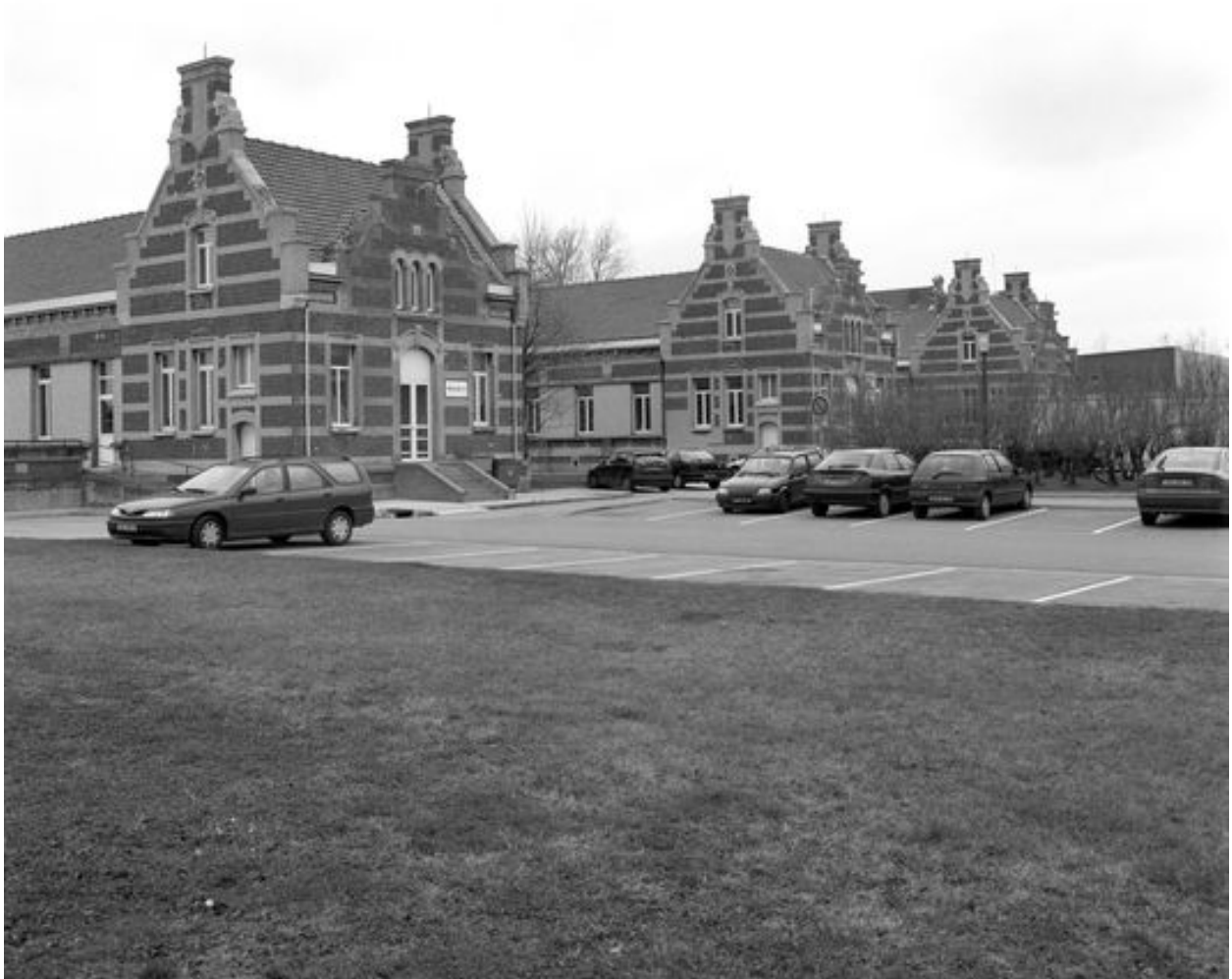
Pavillons des enfants invalides, trois derniers pavillons de l'alignement du groupe ouest, désignés, en allant d'arrière en avant, par les numéros 8, 9 et 10, vue d'ensemble prise de trois quarts gauche.
