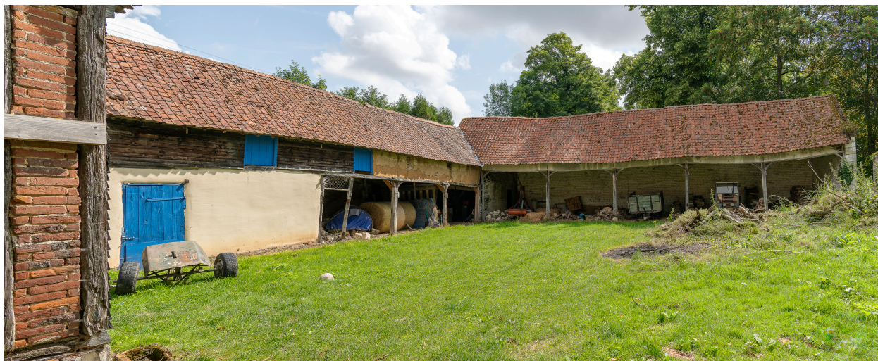
Ancienne basse-cour vue depuis l'ouest.
