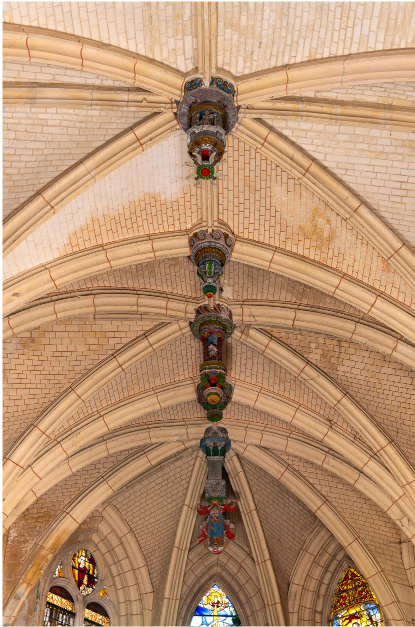
Voûtes, vue vers la chapelle.
