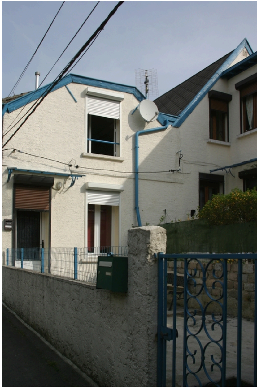
Deux logements de la cour.
