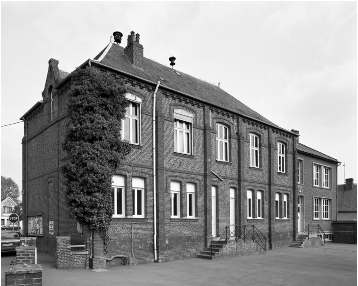
Vue de l'élevation postérieure, depuis le nord-ouest.
