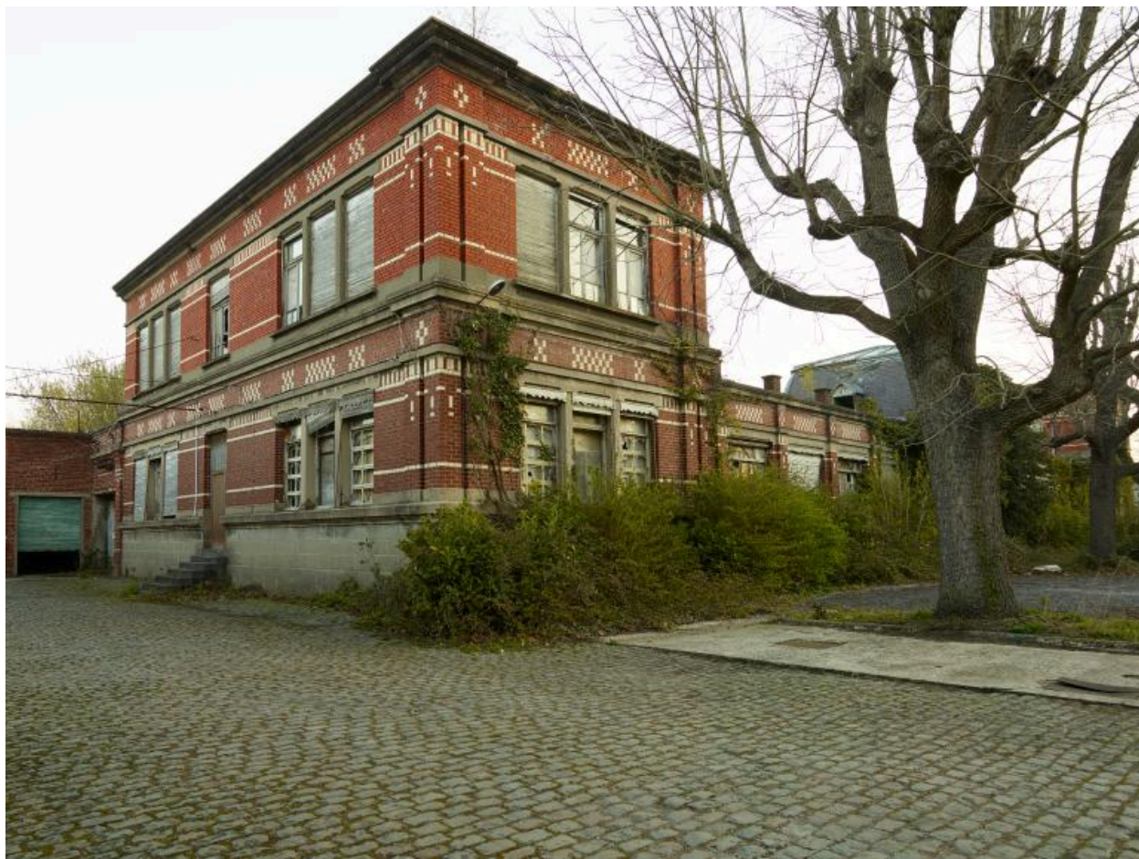
Vue de trois quarts des bureaux. Vue prise vers le nord.
