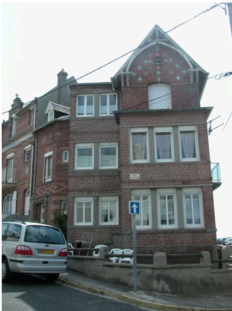
Vue d'ensemble depuis l'angle de rue.
