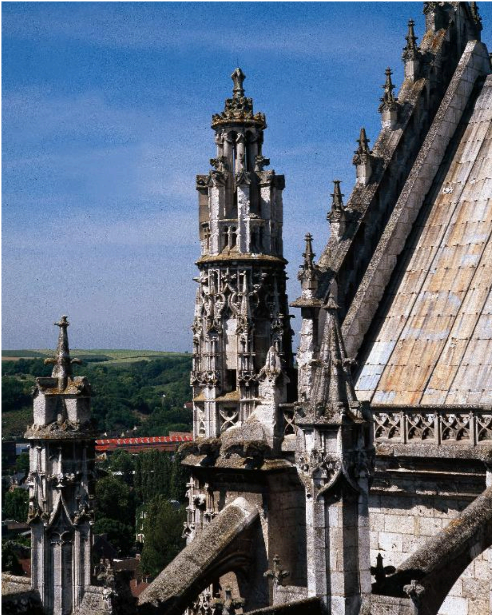
Sommet du bras sud du transept, vu de l'est.
