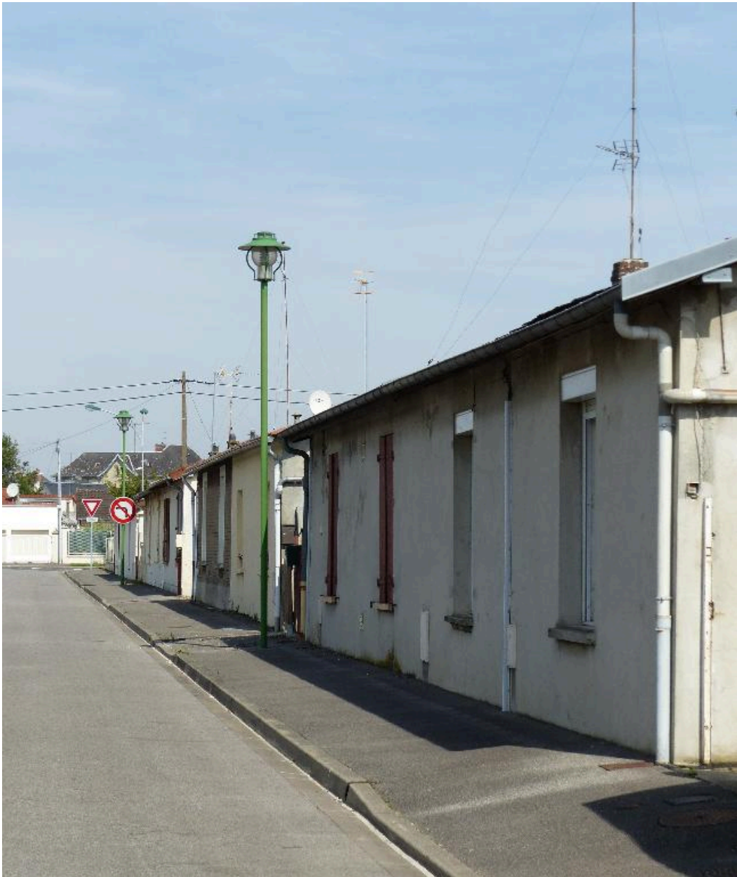
Maisons, rue d'Angleterre.
