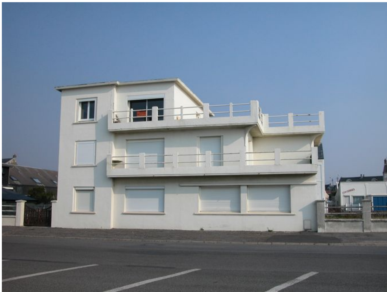
Vue d'ensemble, façade antérieure sur mer.
