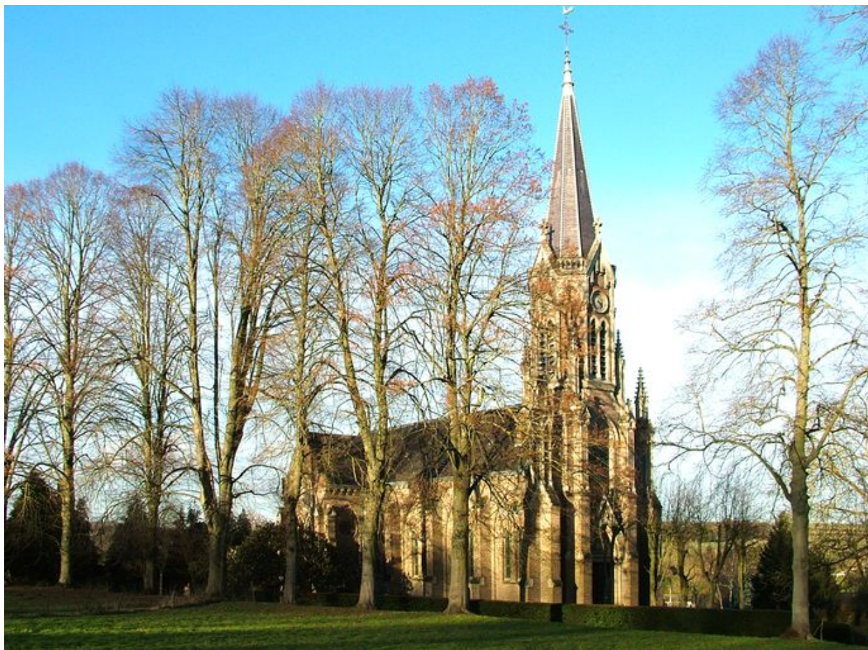
Vue générale depuis le sud.
