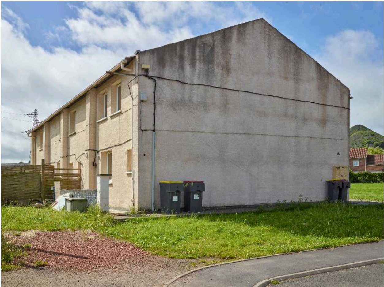
Elévation générale ; chapelle transformée en logements.
