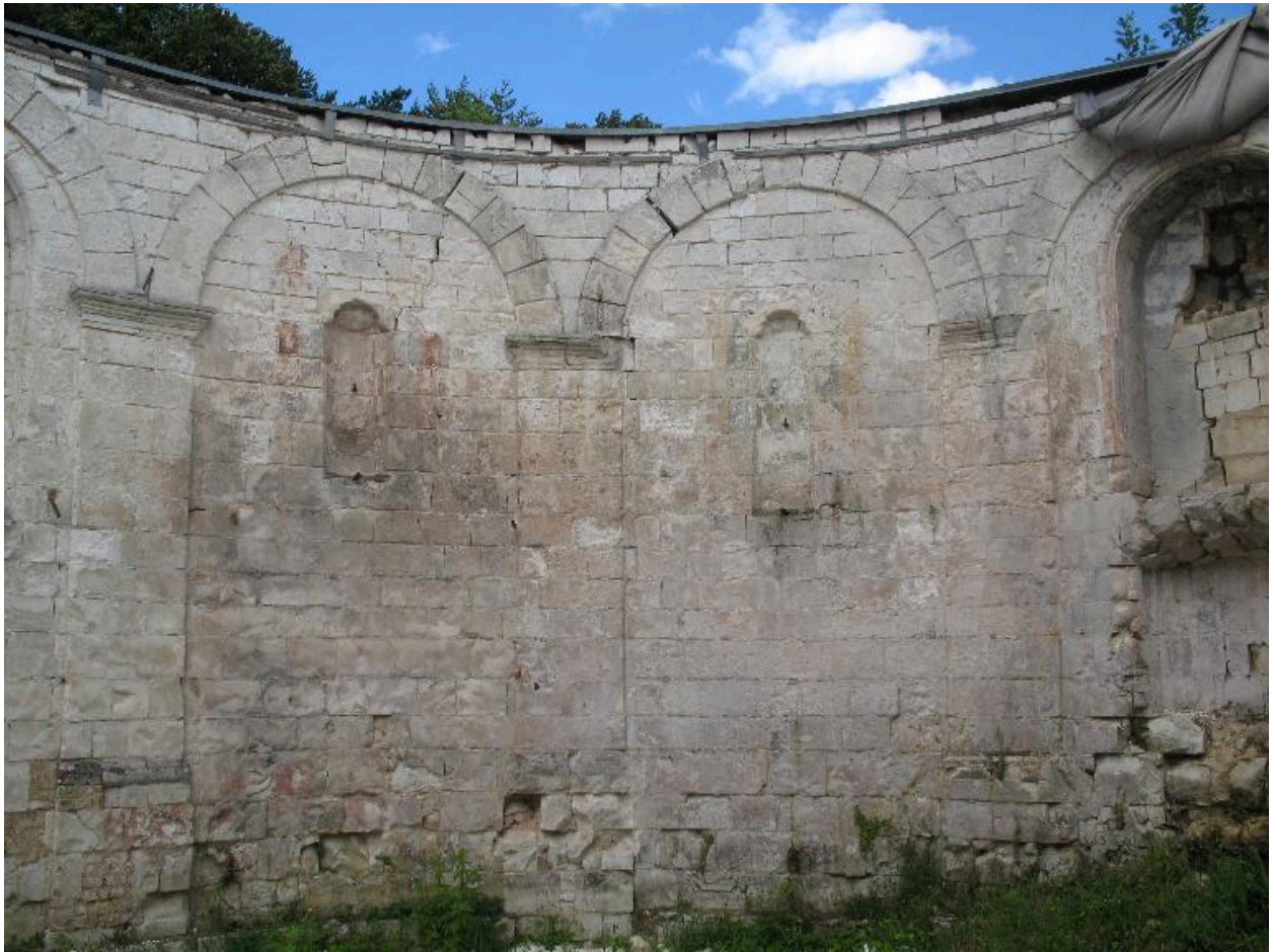
Détail de l'abside, côté nord.
