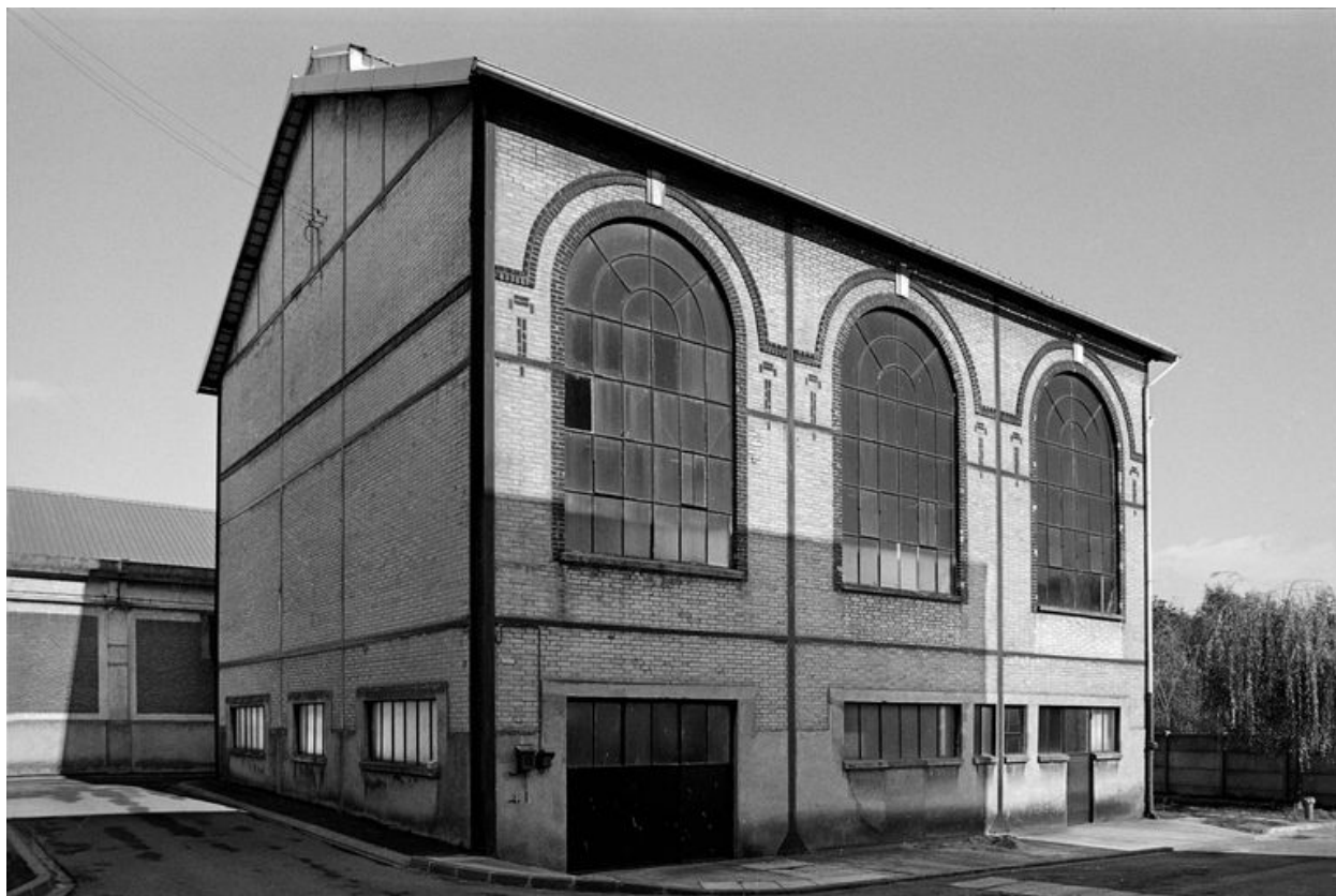
Chaudière, flanc sud.
