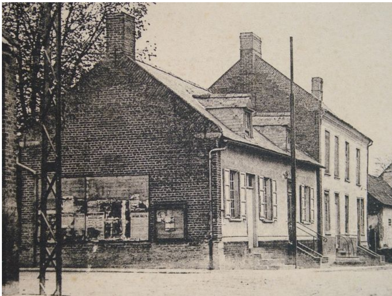
Vue générale de la mairie-école et du logement de l'institutrice, avant 1914 (coll. part.).
