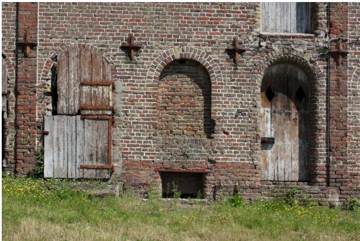
Détail des ouvertures sur cour de la laiterie.
