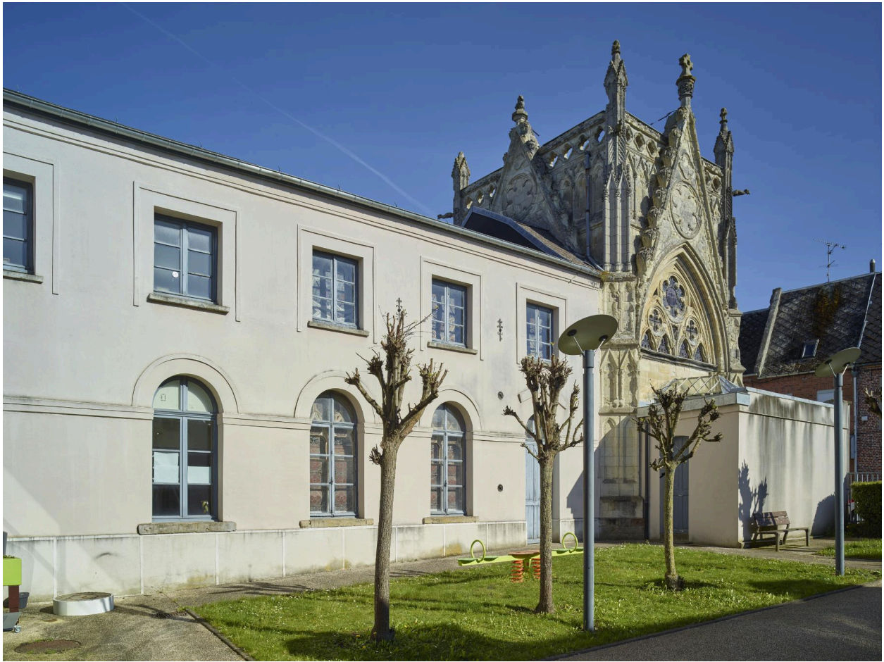
Vue de trois quarts de la façade ouest de la chapelle, orientée nord-sud.
