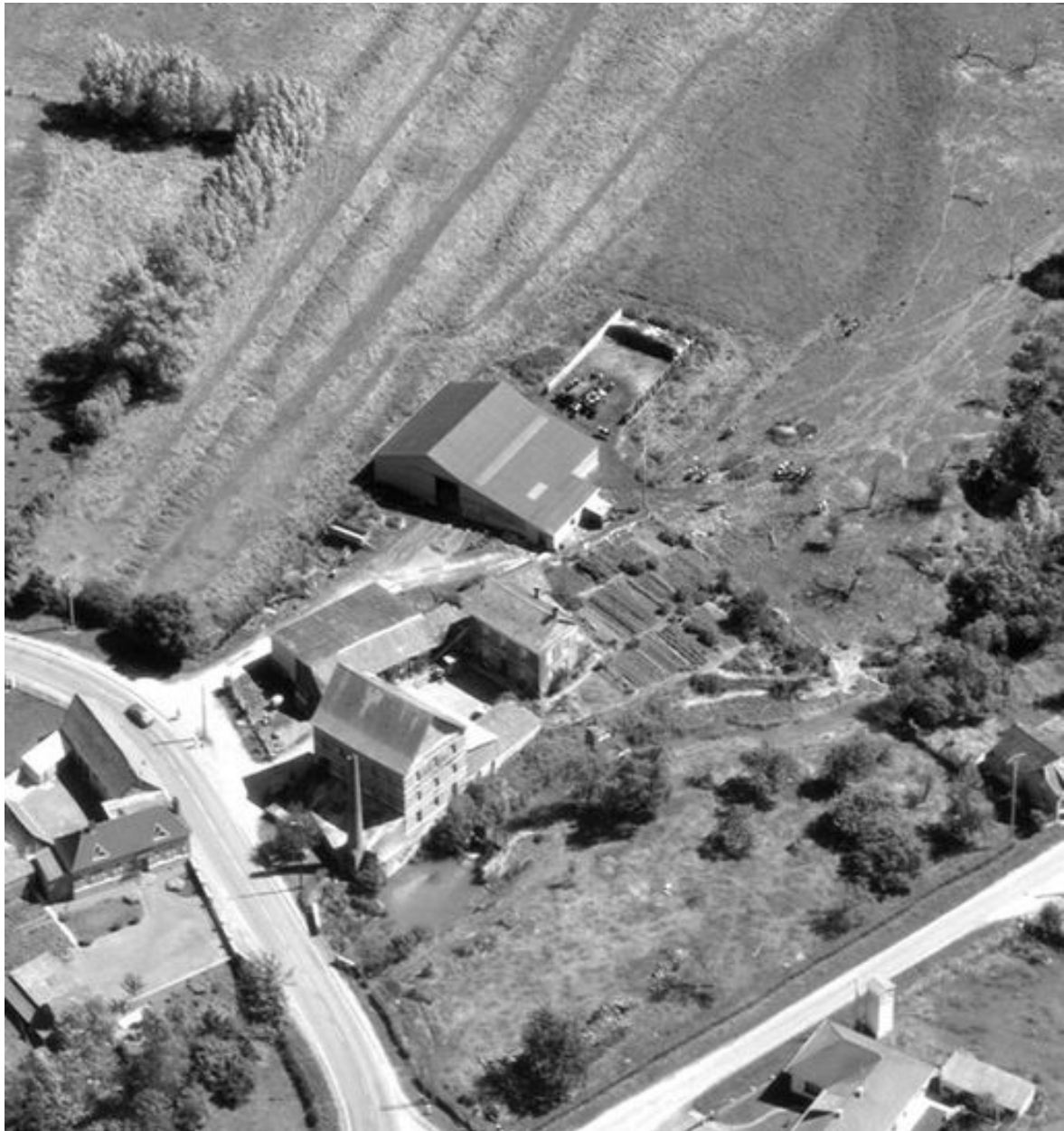
Vue aérienne, flanc sud.
