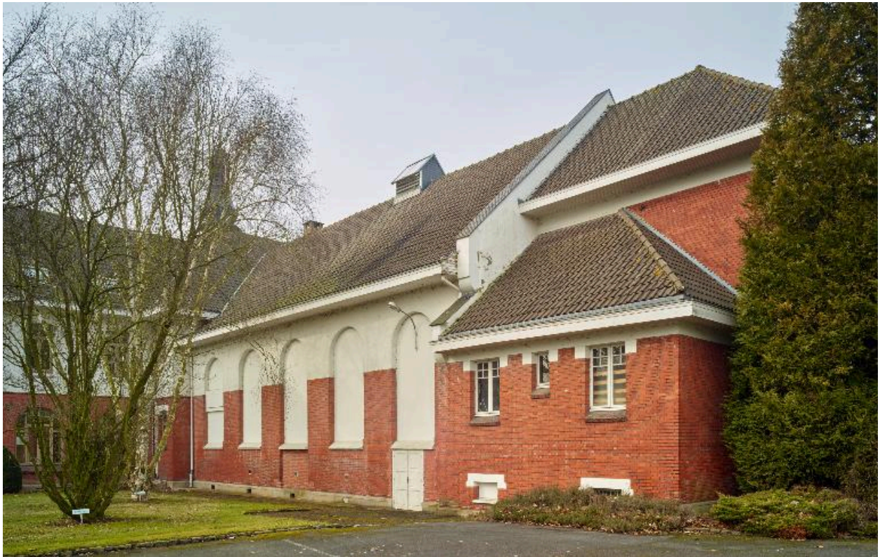
Bâtiment de l'administration, détail de l'aile postérieure en retour d'équerre renfermant la salle de spectacle, élévation latérale droite, vue prise de trois quarts droit.
