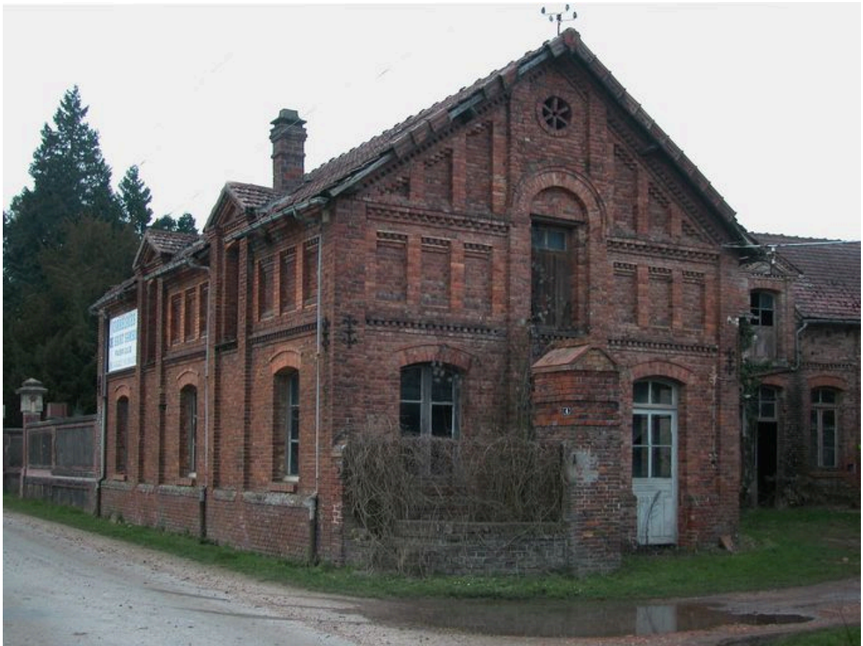
Vue d'ensemble des bureaux.
