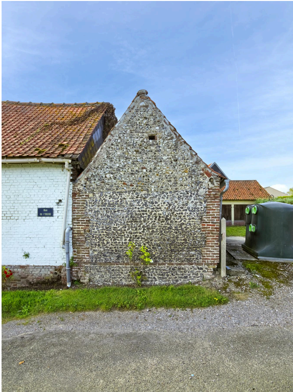
Ferme (1, rue de l'Église). Détail du pignon en silex d'un bâtiment agricole.
