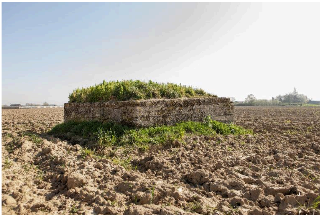
Vue de trois-quarts arrière; vers l'est
