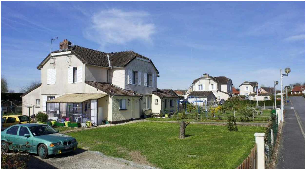
Maison à quatre unités d'habitation (5-7 rue Jean-Jacques Rousseau et 2 et 4 rue Pascal).
