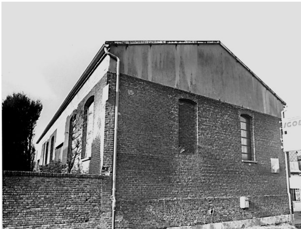
Usine de matériel agricole Fetro-Lefèvre, 15 Grand'rue : atelier de fabrication.
