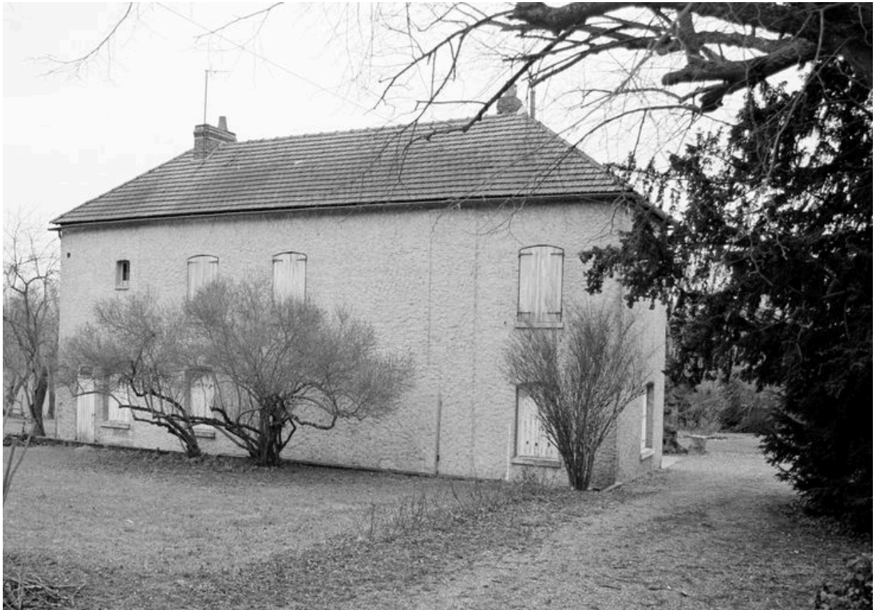
Logement patronal, façade postérieure.
