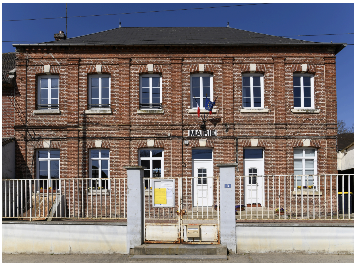
Mairie-école, rue de l'École, vue depuis l'est.
