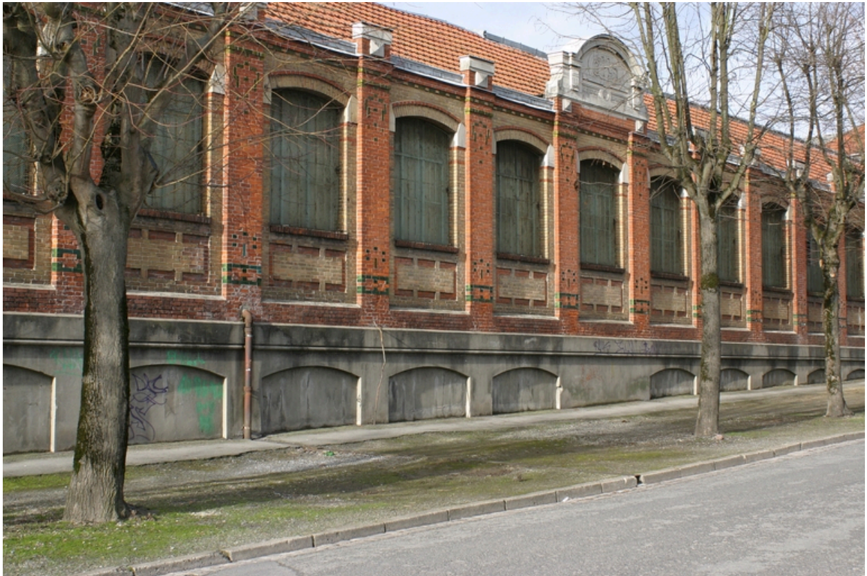
Façade des ateliers : détail.
