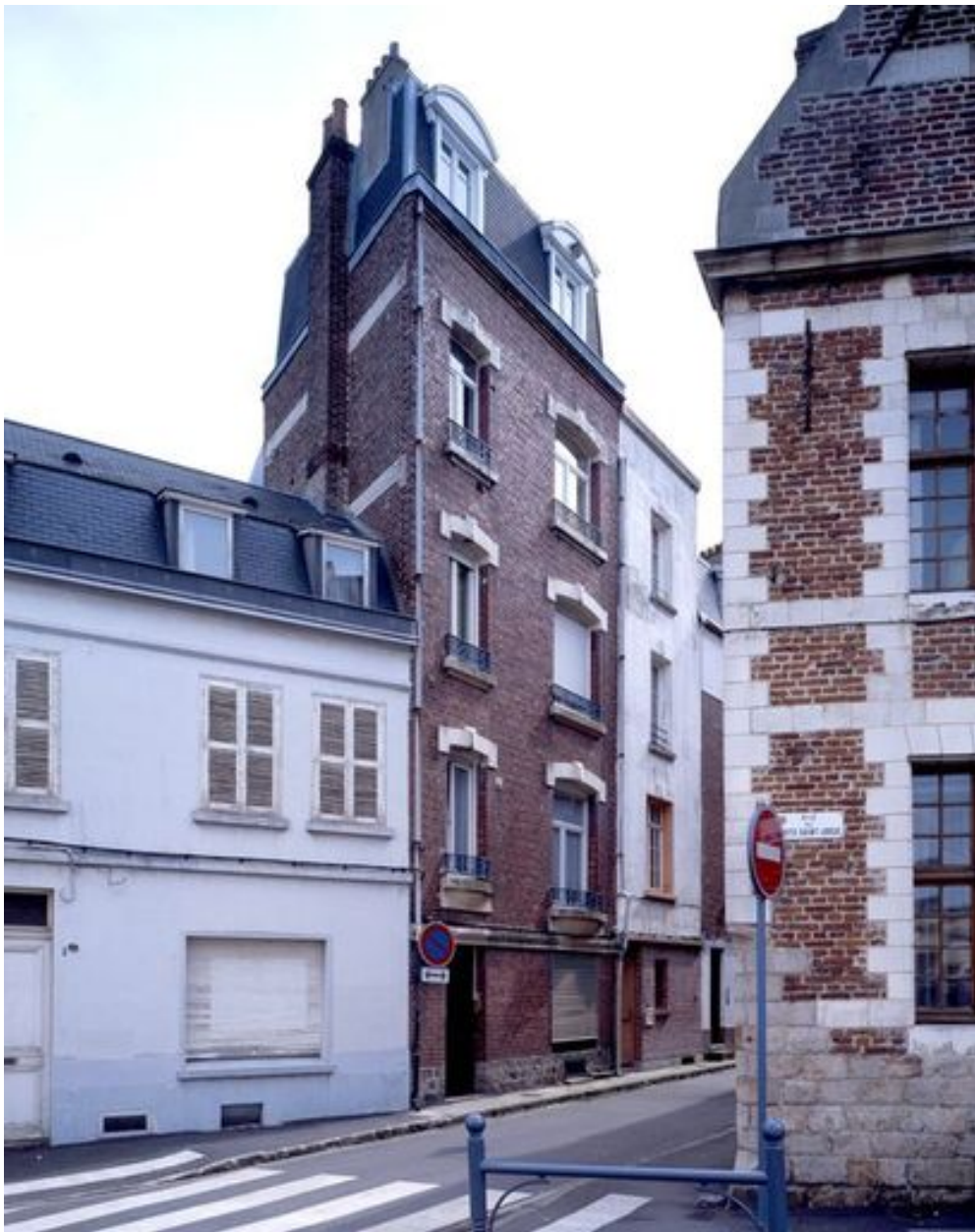
Vue générale, façade rue du Fer-à-Cheval.
