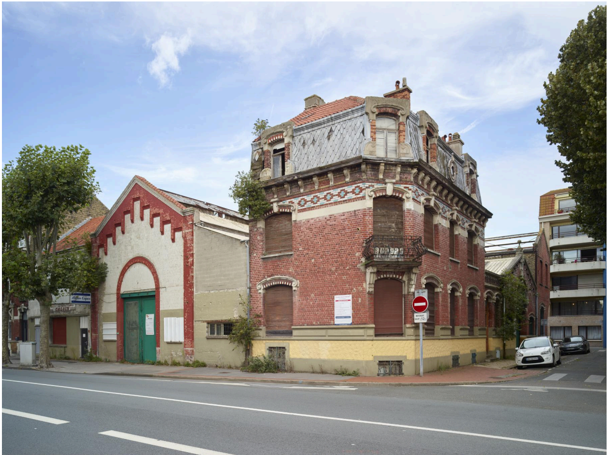
Vue générale vers le nord-est. À l'angle, l'ancien logement patronal.
