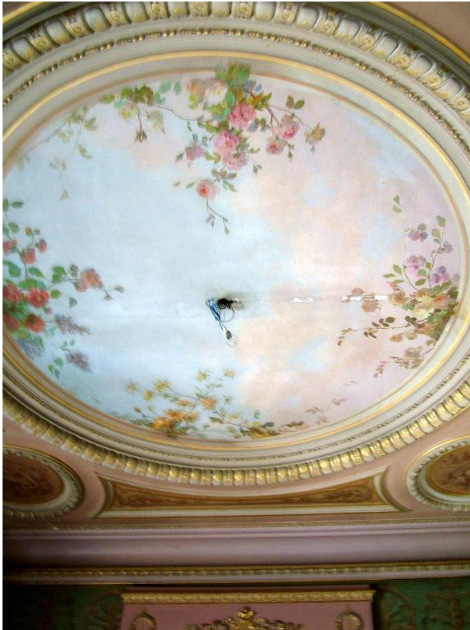
Petit salon, détail du plafond.
