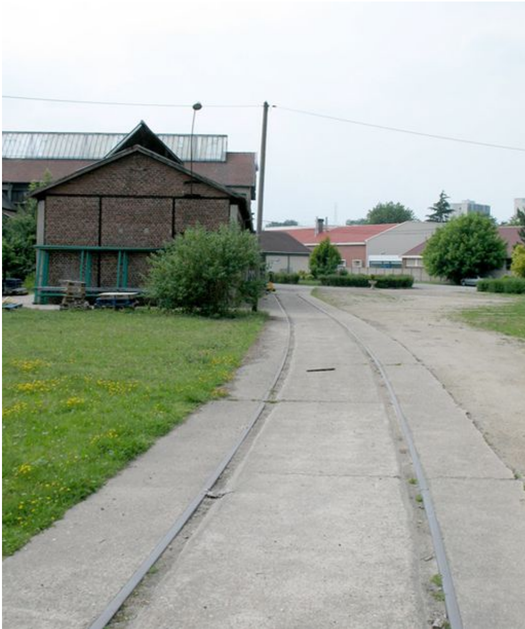
Rails desservant les bâtiments annexes de la fonderie.
