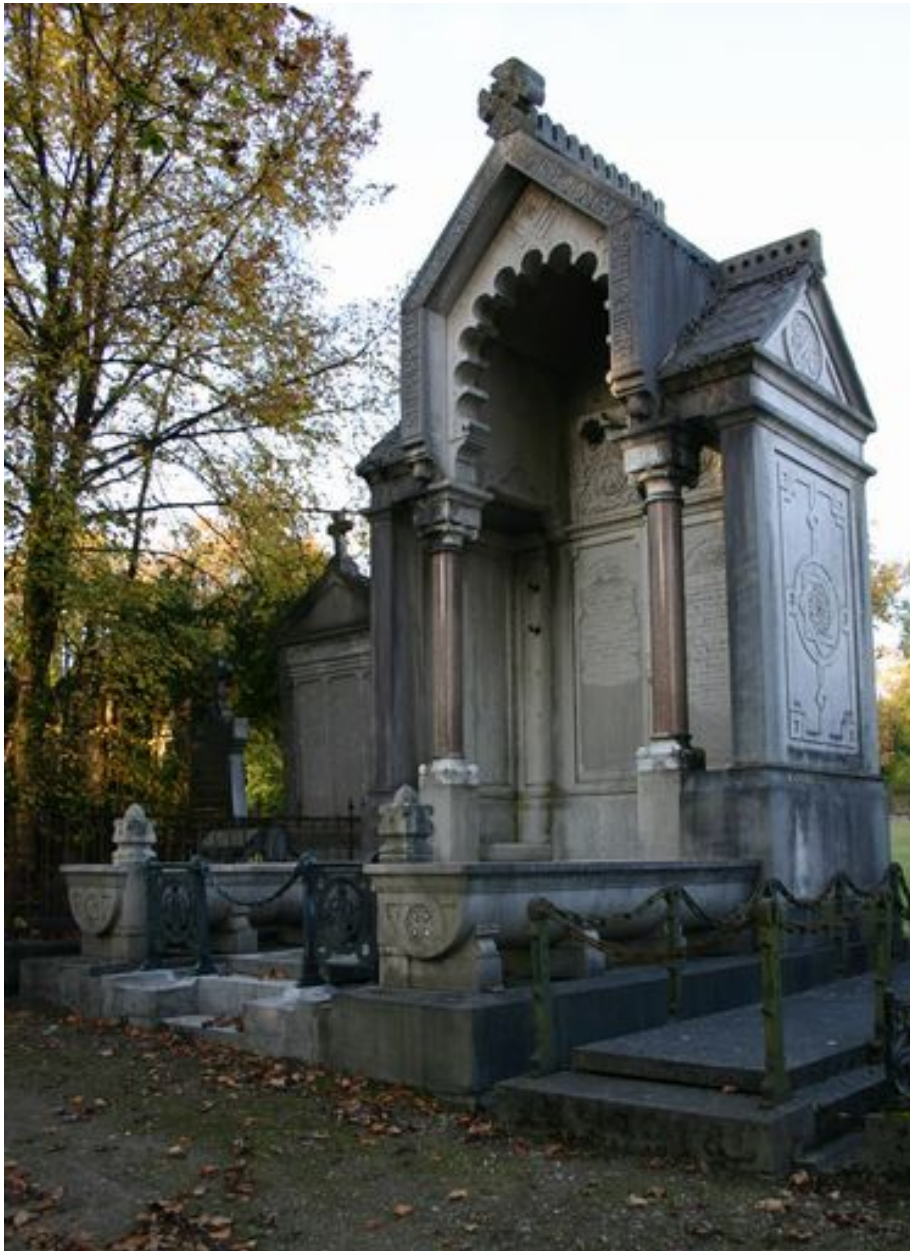
Vue générale, depuis le côté.
