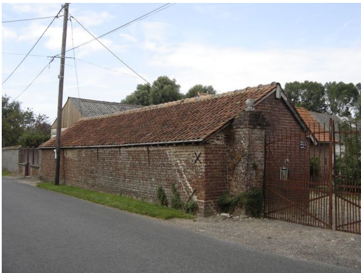
Vue des étables sur rue.
