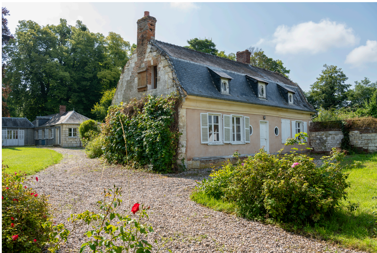
Ancien logement des domestiques, vue depuis le nord-ouest.
