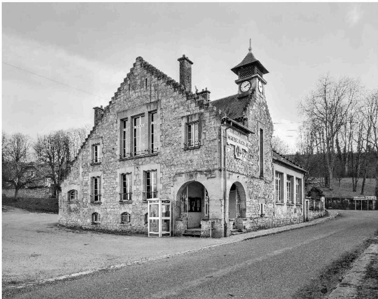
Vue générale de l'édifice depuis le nord.
