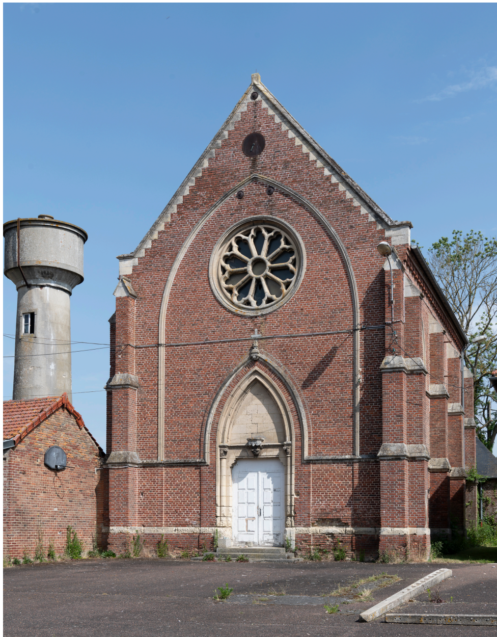
Chapelle, vue depuis le sud-est.
