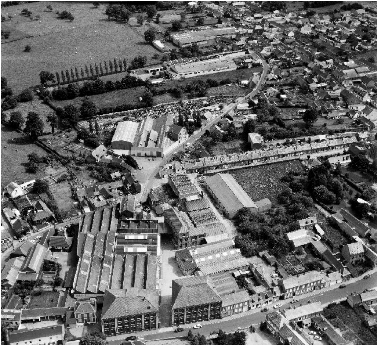
Vue aérienne de l'usine et de la ville depuis le sud, en 1988.
