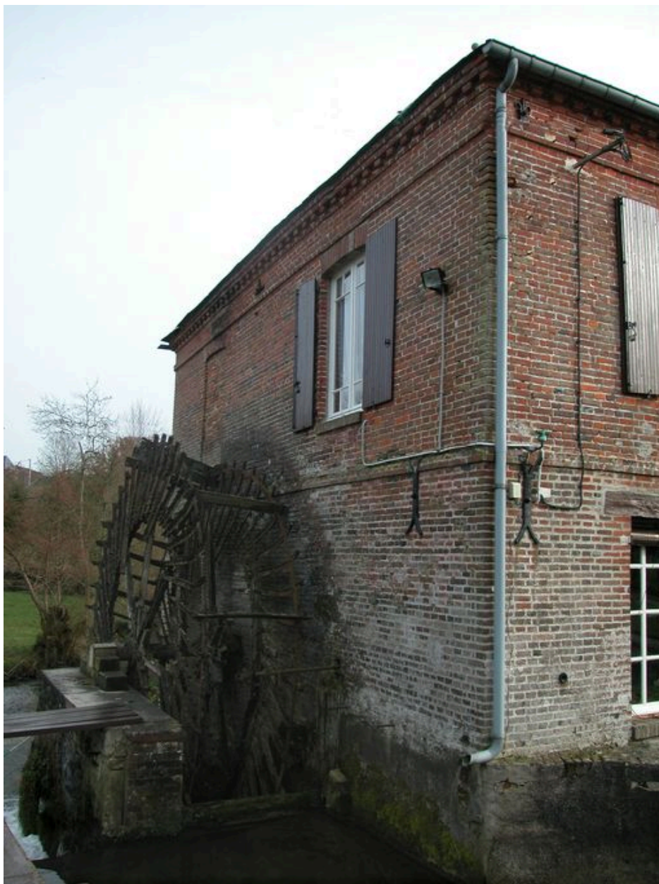
La roue hydraulique, vue de trois-quarts.
