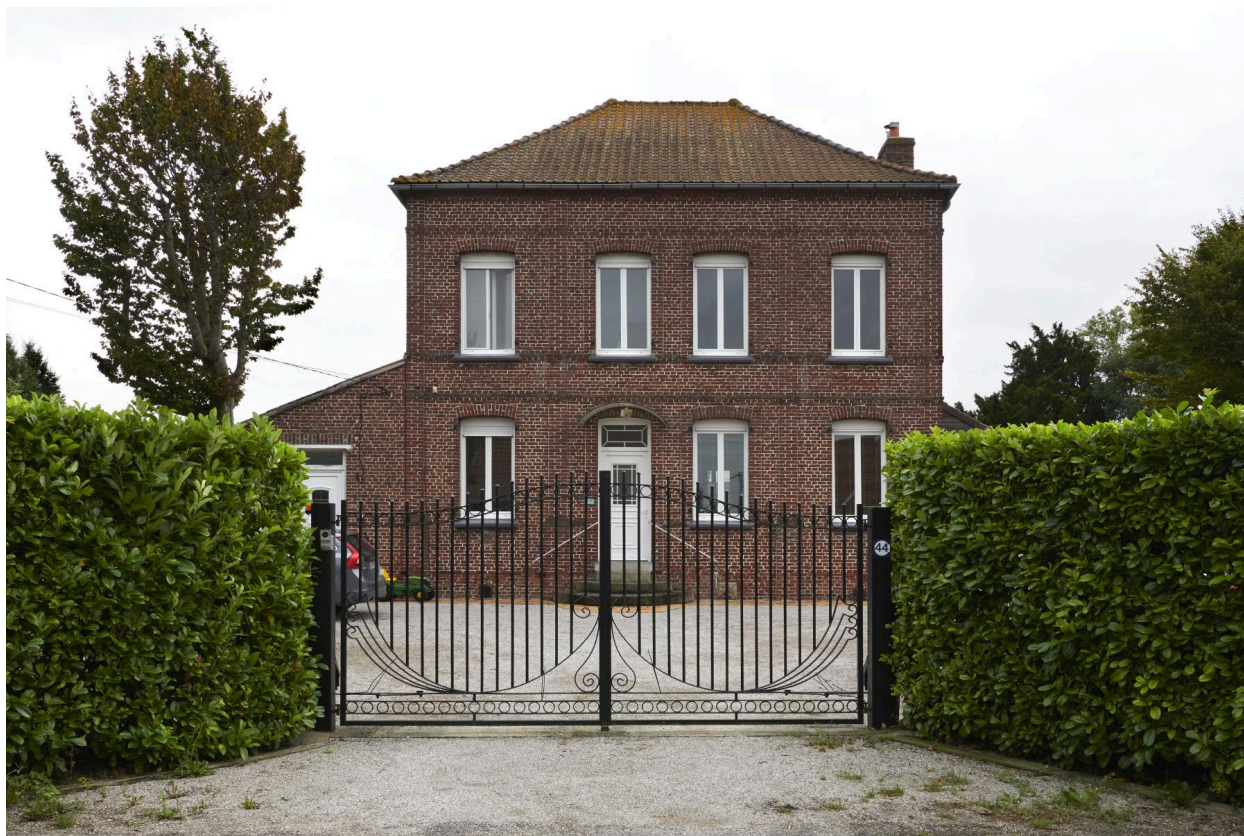
Façade principale de l'ancien presbytère.
